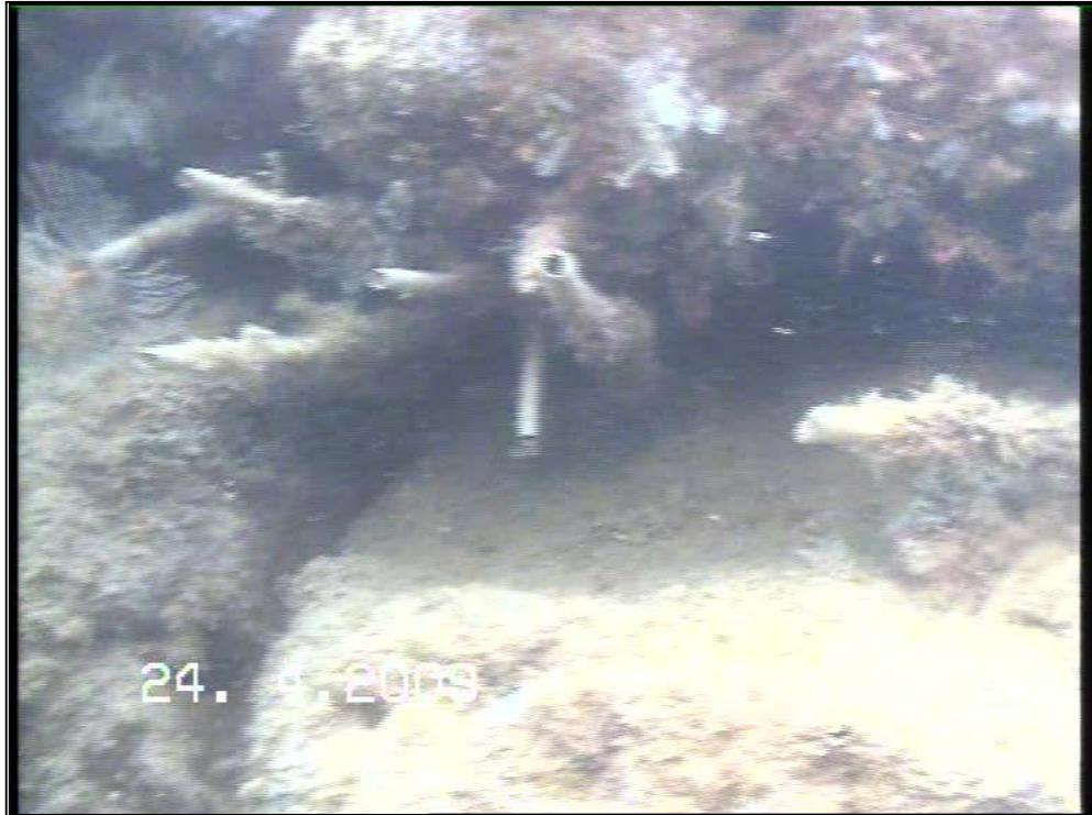
Fig. 2.7 Esempio di giunti beanti tra blocchi, degrado di medio livello.
