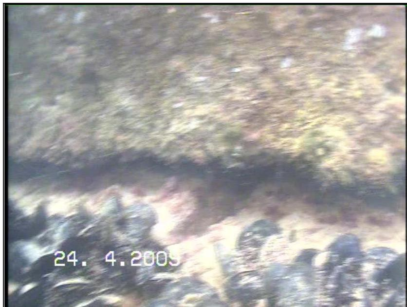
**Fig. 2.8 Esempio di giunti beanti tra blocchetti (fascia super.) e blocchi (fascia infer.), al
