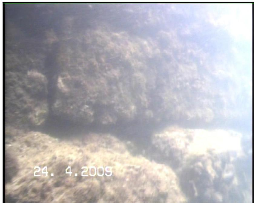
**Fig. 2.1 Sez. 40: Contatto tra blocchetto (posiz. superiore) e blocco (posiz. inferiore) con presenza di giunti beanti (cavità di piccola dimensione); i blocchi in posizione non allineata rispetto alla fila superiore.**
