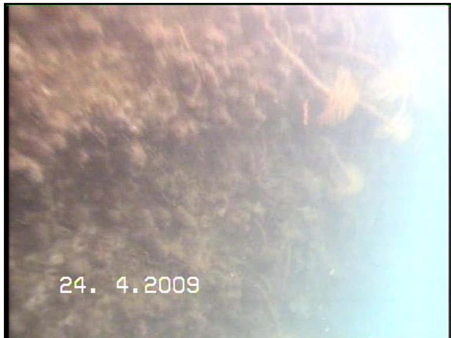
Fig. 2.14 Sez. 110 Parete verticale con blocchi disallineati, presenza di scarso *fouling*.
