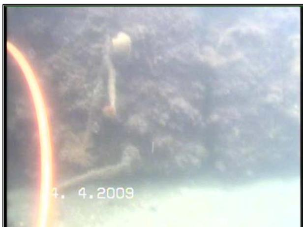
**Fig. 2.5 Erosione alla base della banchina (situazione generale tra sez 40-96).**
